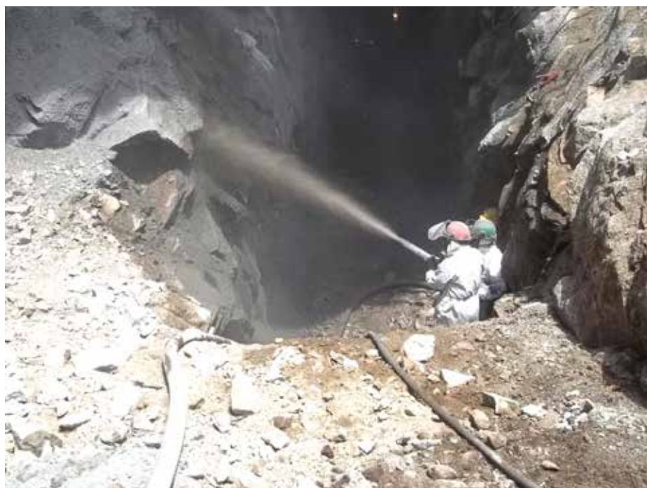
Para el sostenimiento con shotcrete, pueden utilizarse colocadores manuales o robotizados.
