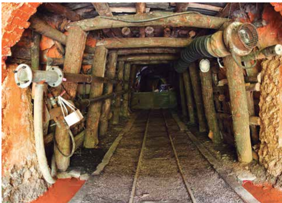
En espacios subterráneos, por lo general, el material recomendado para el sostenimiento es la madera.
