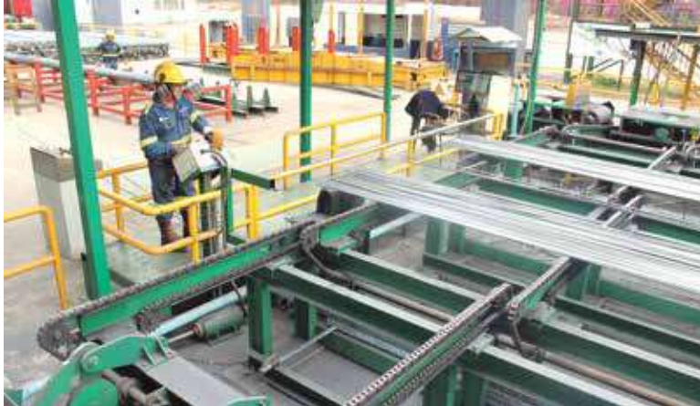
Siderperu realiza la verificación del correcto estado de las varillas de acero.
