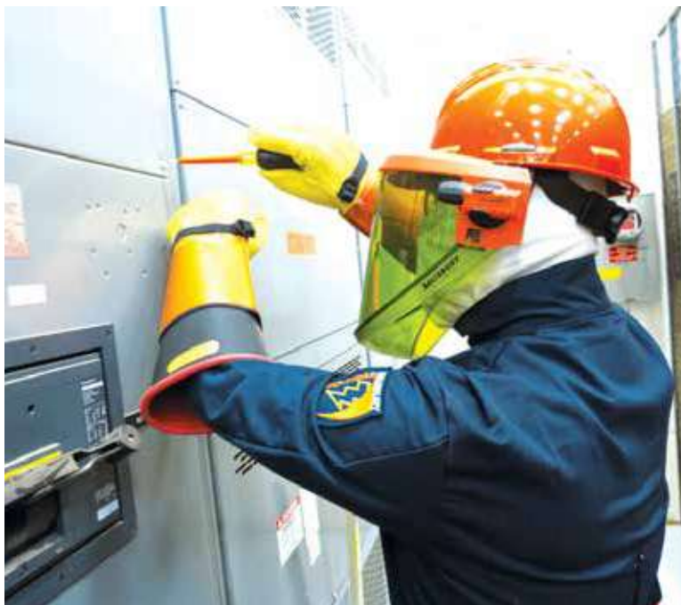
En áreas energizadas, el operario capacitado debe vestir equipos protectores.
