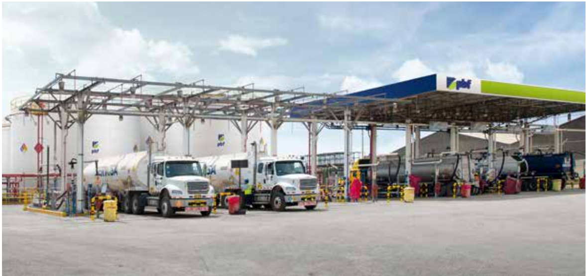
Planta de almacenamiento y abastecimiento, ubicado en el Callao, que almacena 42 millones de galones de combustible líquido.
