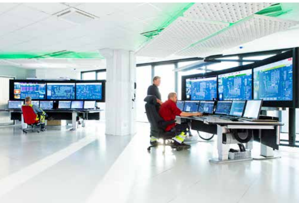
El System 800xA permite controlar las áreas de la planta, los sistemas de control y electrificación, el centro de control principal y el gerenciamiento de información.
