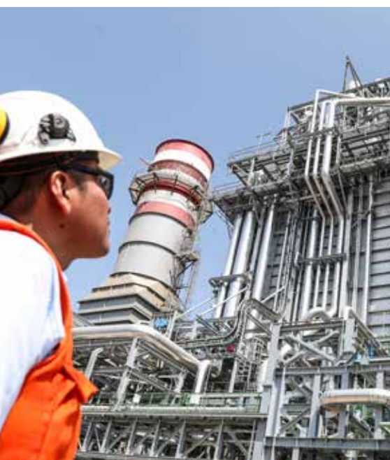
El segmento de comercialización eléctrica representa una actividad complementaria al proceso físico de generación y transporte.
