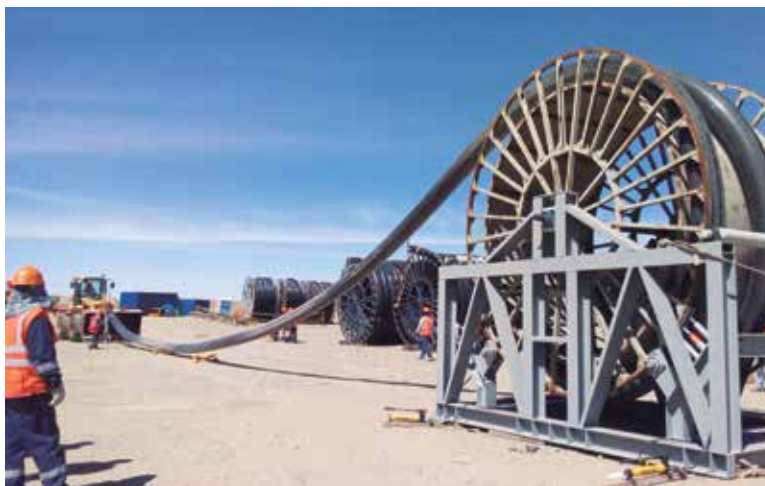
Las tuberías en bobinas Pexgol generan interesantes ventajas en el transporte, tendido, instalación, montaje y operación para el manejo de relaves, pulpas, agua, y soluciones ácidas en general.
