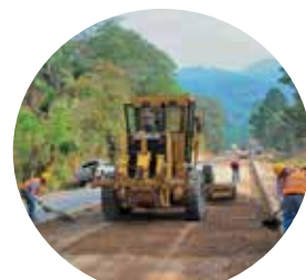
MANTENIMIENTO DE VÍAS
