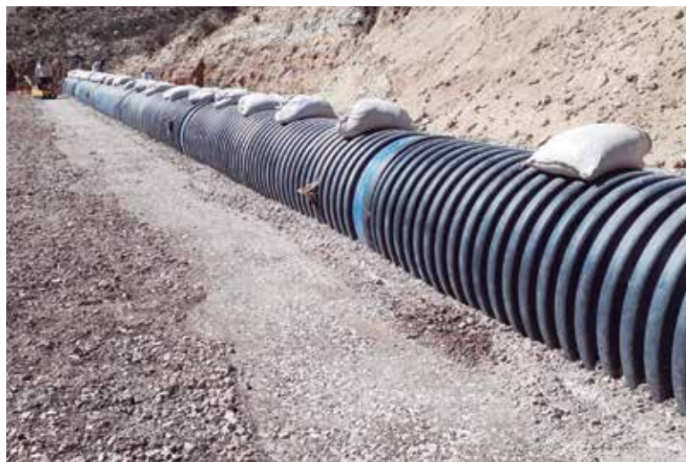
Los tubos corrugados de Polietileno de Alta Densidad (PEAD), son resistentes a la corrosión y la abrasión e inmunes a muchas reacciones químicas y electroquímicas.
