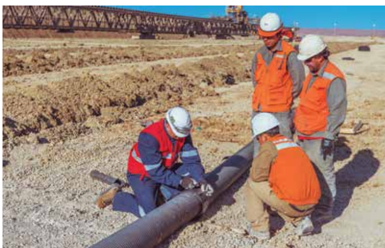
Las tuberías corrugadas PEAD son muy usadas para las alcantarillas viales en las carreteras internas de las minas.
