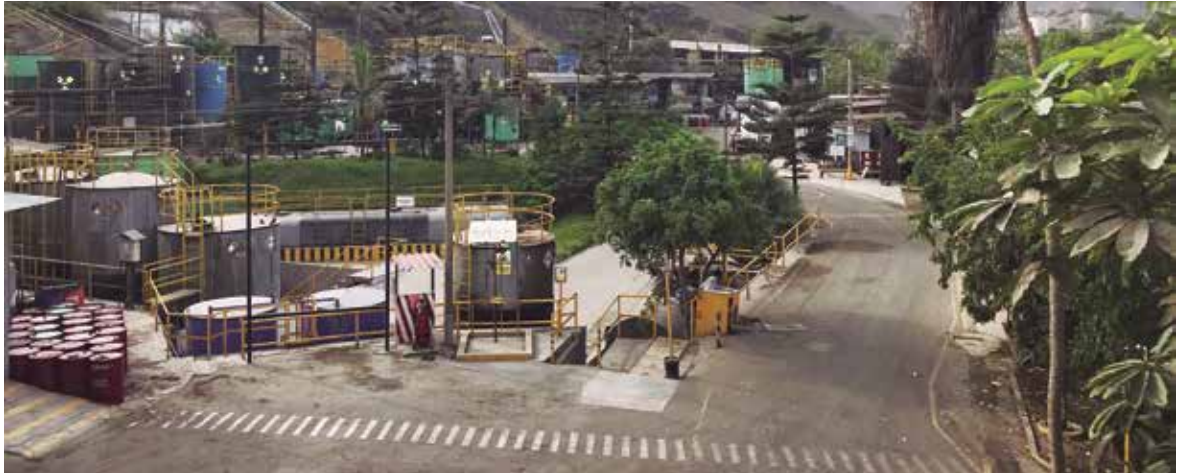
La empresa ofrece el servicio de evacuación, transporte y reciclaje -o disposición final- de todos los residuos que recogen.
