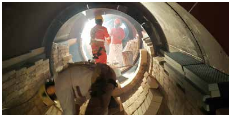
ITACAMBA cemento, cambio de ladrillos refractarios.
