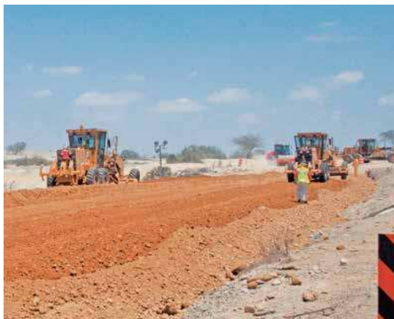
Sea en construcciones viales o en caminos mineros, las motoniveladoras son el equipo necesario por los contratistas para uniformizar el terreno y nivelar taludes.
